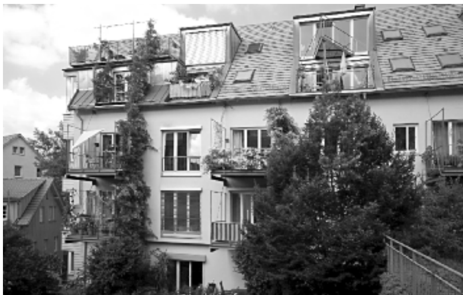
Energetische Sanierung der Bauherrngemeinschaft „Schnapsfabrik“ in Stuttgart Süd, Heusteigviertel. Mix aus Eigentums- und Sozialwohnungen, Energieversorgung durch eigenes Blockheizkraftwerk und Wärmepumpe.
