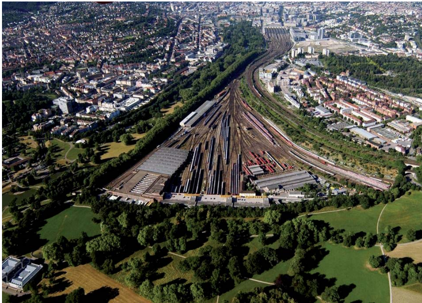
Heute: Der Abstell- und Wartungsbahnhof direkt am Stuttgarter Hauptbahnhof.
