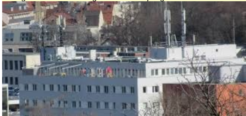
Dach der Schwabengarage am Neckartor. Blick auf den Dachgarten der Kindertagesstätte mit Spielgeräten
